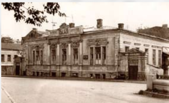
Здание на Собачьей площадке, д.5 / 5.Sobachiya plochadka
